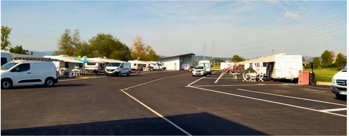
Réfection de l'enrobé avec pose de rails d'ancrage pour fixer les auvents
