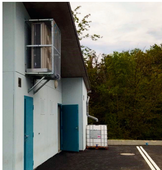
Bloc des sanitaires avec pompes à chaleur et récupérateur d'eau de pluie
