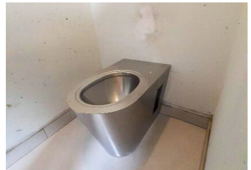
Installation de nouveaux WC assis
