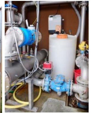
Remplacement de l'UV à Niederhaslach
