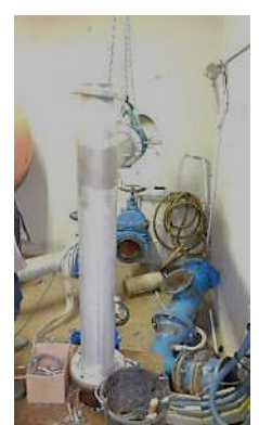
Remplacement de la tuyauterie du puits de Griesheim 3
