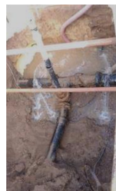
Remplacement de la tuyauterie du puits de Griesheim 3
