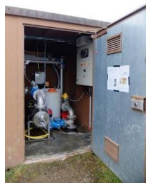
Remplacement de la tuyauterie du puits de Griesheim 3
